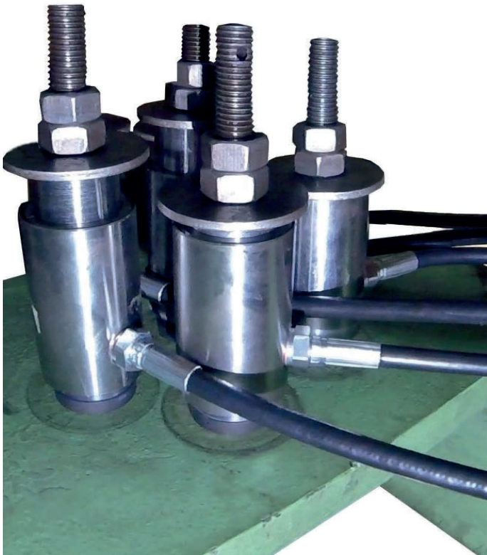
Abbildung 7: Einbausituation an einer realen Aufzugsanlage. Deutlich sind die ehemals ungleichmäßigen Seilspannungen an der Ausfahrlänge der Zylinder erkennbar.
